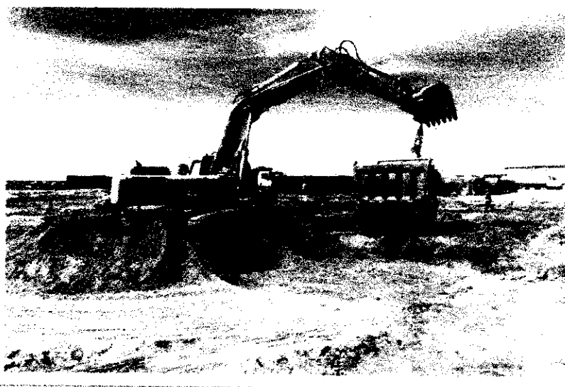
CORTE MASIVO DE TERRENO CON MÁQUINA
